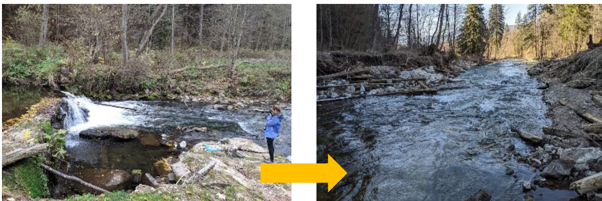
Obrázok č. 7. Rieka Hron, lokalita Pohorelská Maša. Bariéra v zlom technickom stave s rizikom pre ochrany pred povodňami. V r. 2019 ju WWF Slovensko pripravovalo na odstránenie, po získaní 18 súhlasov a povolení v roku 2020 stupeň zničila povodeň. Zvyšky stavby následne odstránil správca toku v rámci údržby.
