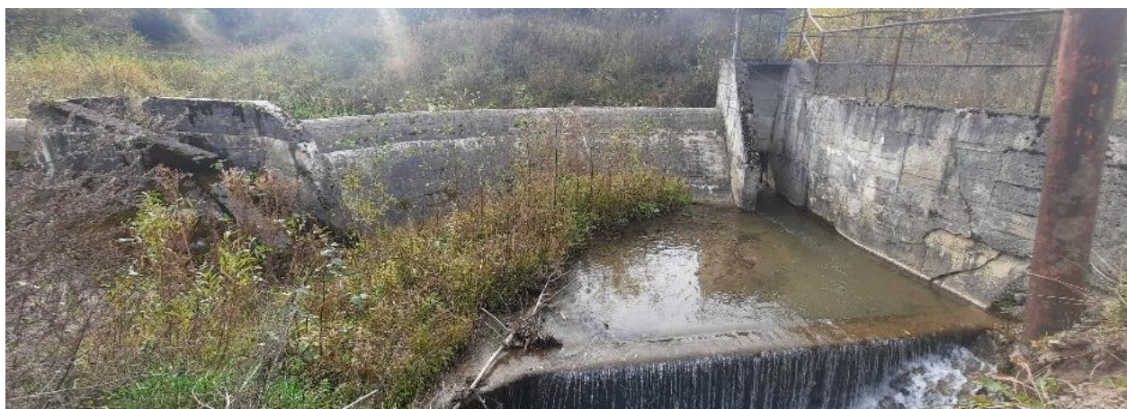
Obrázok č. 6. MVE na potoku Krivá (okr. Tvrdošín) – úplne nepriechodná migračná bariéra na vodnom toku pôvodne slúžila ako súčasť objektu MVE. MVE je v súčasnosti nefunkčná, nepracuje.
